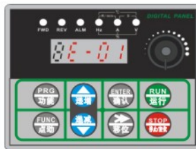
图1-5 加速中过流故障报警显示
